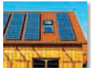
En el techo de esta casa hay celdas solares que producen electricidad. Unas baterías almacenan parte de esa electricidad para usarla en los días nublados o durante la noche. Esta casa, además, tiene claroboyas que dejan entrar luz en las habitaciones que, de otro modo, estarían a oscuras.
